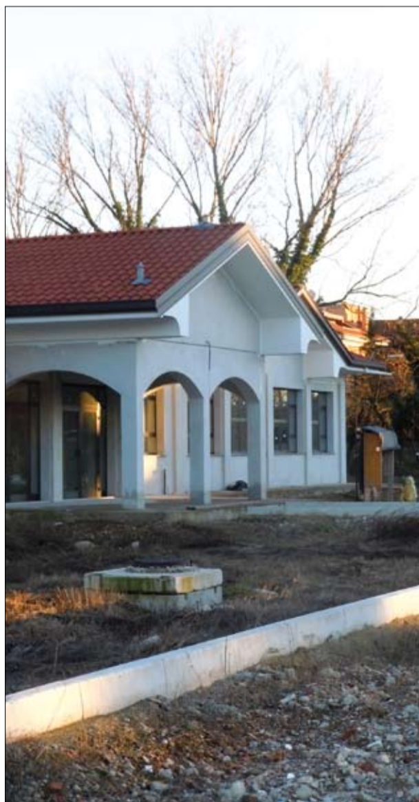
IL CANTIERE DEL NUOVO CENTRO CIVICO DI SAN BOVIO.
